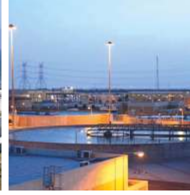
Batı Doha Arıtma Tesisi
