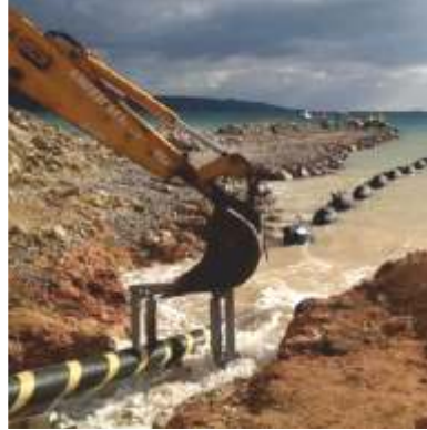
Terna Peloponne & Girit Enerji Hattı Bağlantı Projesi
